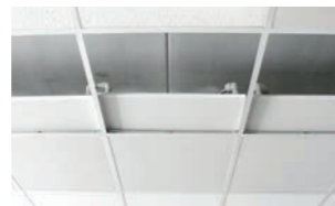
Die Modul Klimadecke 60/60 in die Gipskassette integriert. Die Lösung bei Rasterdecken.
