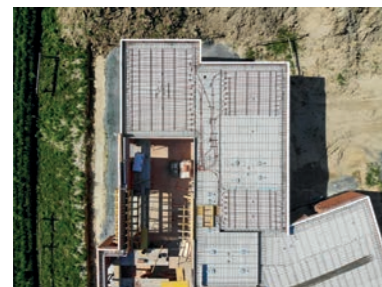
Oben: Betonkernaktivierung mit Ortbeton.
