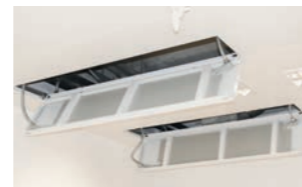
Das Modul mit Revisionsöffnung ermöglicht eine einfache Wartung bzw. die Neuinstallation und Ergänzung technischer Leitungen - wie hier in einem Krankenhaus.
