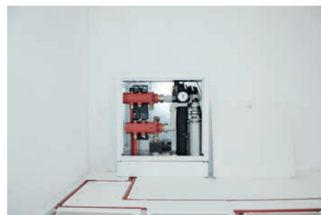
Dieses Kellerabteil wurde nachträglich zu einem Fußpflegestudio umfunktioniert. Die Komfort-Energiestation stellt bei Bedarf, unabhängig vom restlichen Haus, Energie bereit, welche durch den Modul Klimaboden rasch und gleichmäßig verteilt wird. Komfort auf Knopfdruck.
