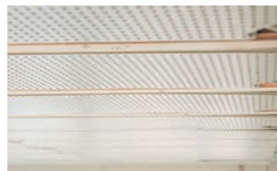
Mit Holzstaffeln direkt auf die bestehende Decke oder Dachschräge montiert.
