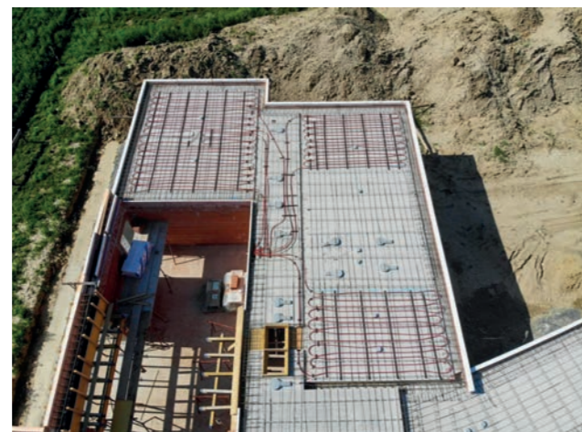
Oben: Betonkernaktivierung mit Ortbeton.
